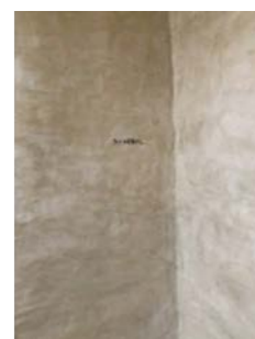
写真3 ピット内状況
