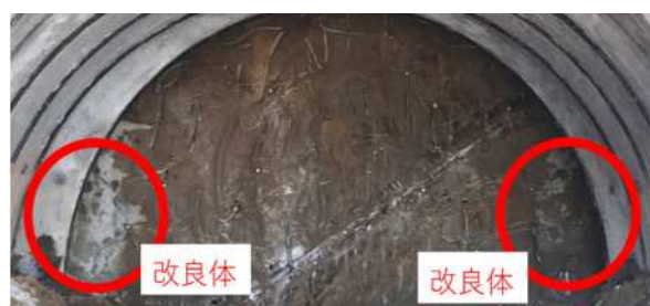
写真-1 改良区間の切羽状況
