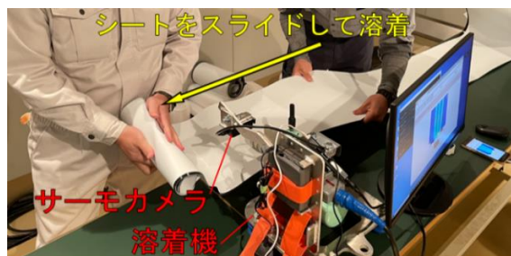
写真-2 防水シート溶着試験状況
