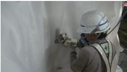
写真-1 防水シート溶着状況
