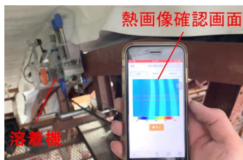
写真-4 現場での熱画像確認状況
