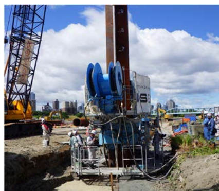
写真-3 後行鋼管矢板打設
