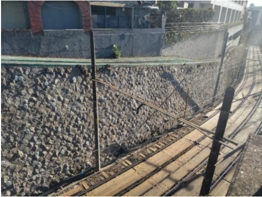
写真-2 工事完了
