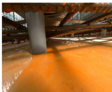
図 5 円筒型枠下清掃状況確認
