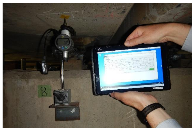
写真2 変位計と遠隔モニターPC
