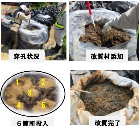
写真－3 高含水土壌の改質状況
