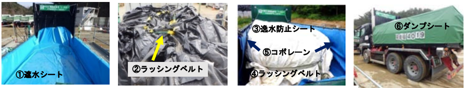
写真－4 輸送ダンプ逸水防止対策
