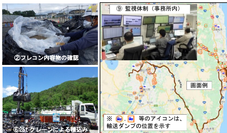
写真-1 輸送工事の主な作業状況
