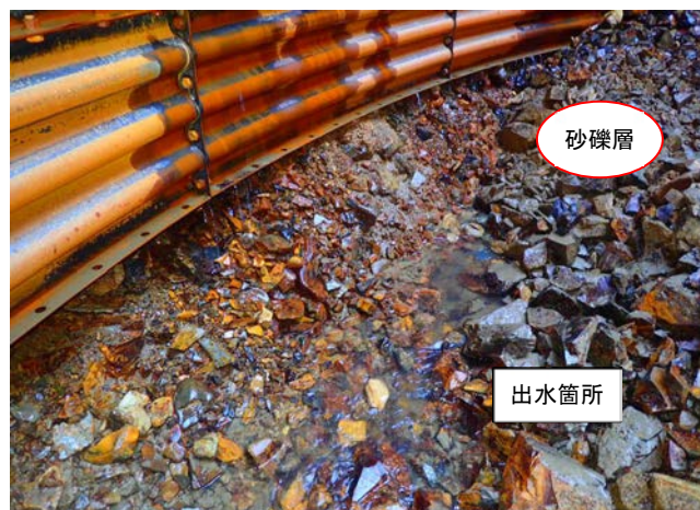
図-3 出水時掘削状況
