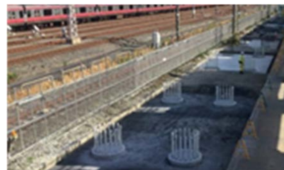
図-7 場所打ち杭施工完了
