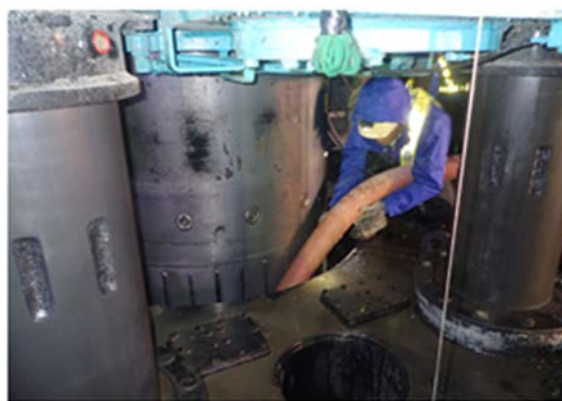
図-5 スライム除去状況
