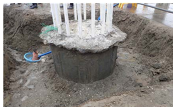
図-6 杭頭部コンクリート充填状況（対策後）
