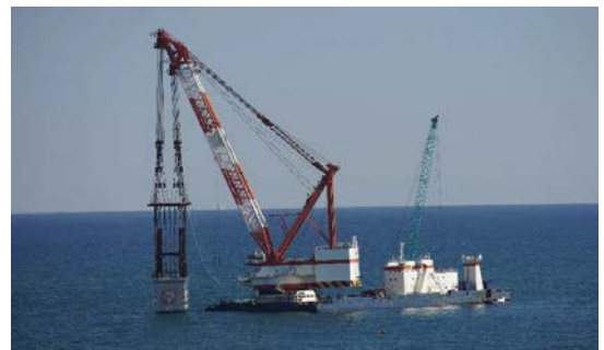
写真-4 ケーソン据付状況
