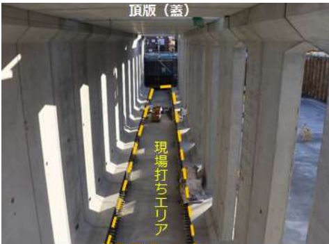
写真－1 上流水槽構築状況
