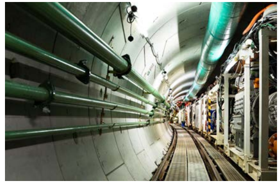
写真-3 放水トンネル内部
