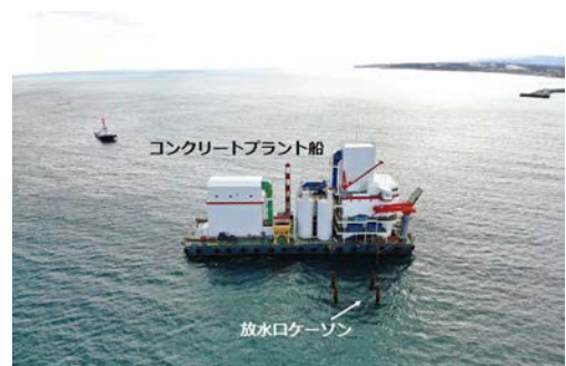
写真-5 ケーソン埋戻し状況
