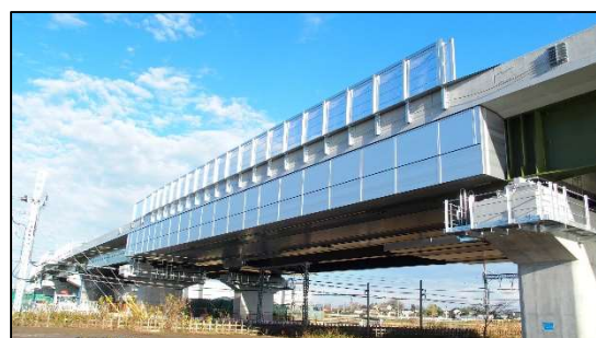
写真-4 施工完了状況
