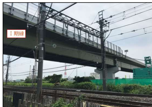
写真-1 東武鉄道との交差状況
