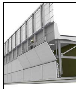
図-2 開閉式側面パネル
