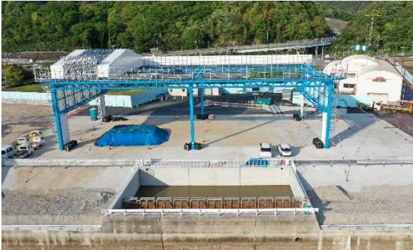
図-6 異常気象対策時の仮設上屋
