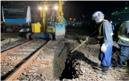
図 4 道床交換始端の両側の口開け
