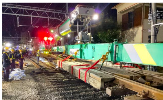
【写真 2】終点方 72 号分岐器+連接軌道撤去
