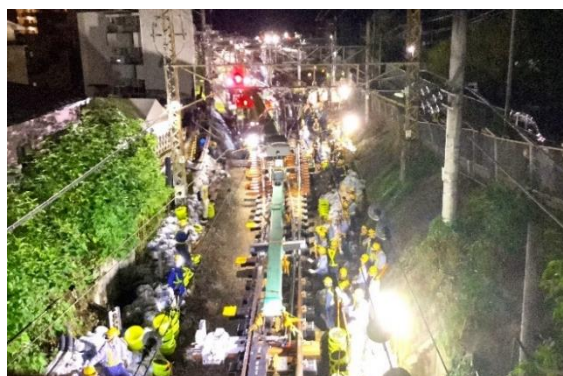
【写真 1】起点方 61 号分岐器敷設時
