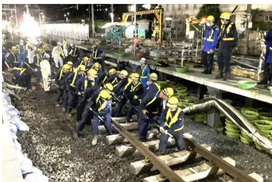
【写真 3】終点方上本線 線路移動
