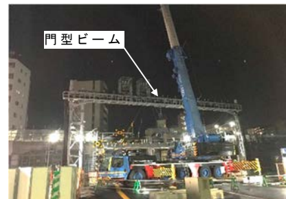
写真－3 桁架設
