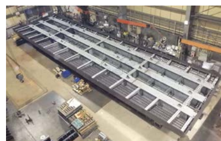
写真-2 H鋼埋込桁の仮組状況
