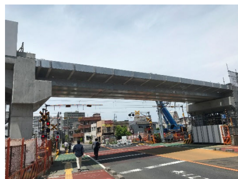
写真-1 H鋼埋込桁の施工完了
