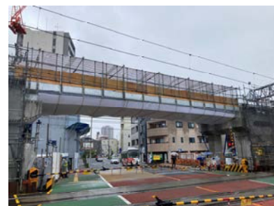
写真－4 桁下のシート養生
