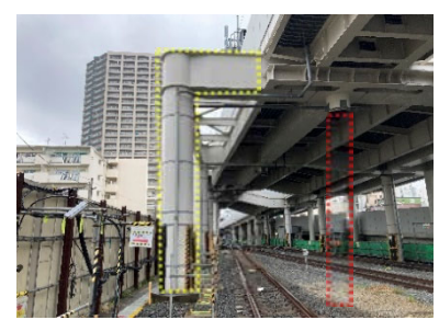
写真-3 高架橋断面
