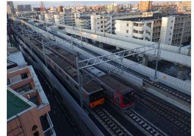
写真-2 高架化切替完了
