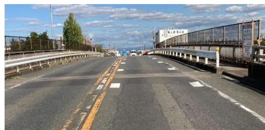
写真-2 PC跨線道路橋
