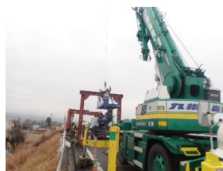
写真-2 吊り架台組立
