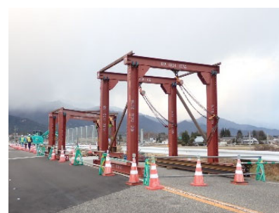
写真-1 吊架台（荷降装置・据付装置）
