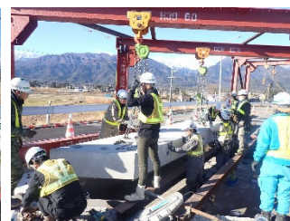
写真-5 踏掛版 据付
