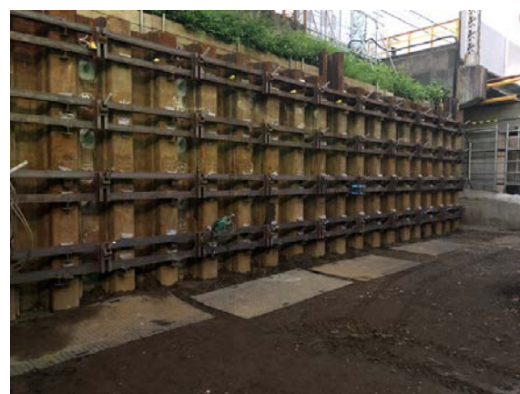
写真 2 地山補強材打設完了
