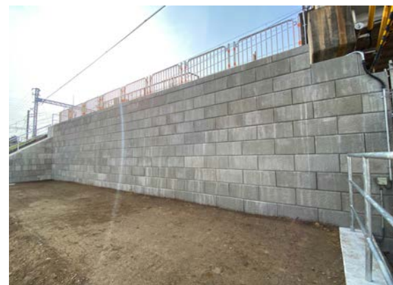
写真 3 橋台背面切土擁壁化工法完成状況
