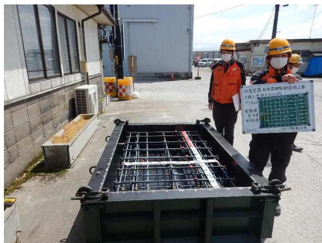
写真-1 配筋検査
