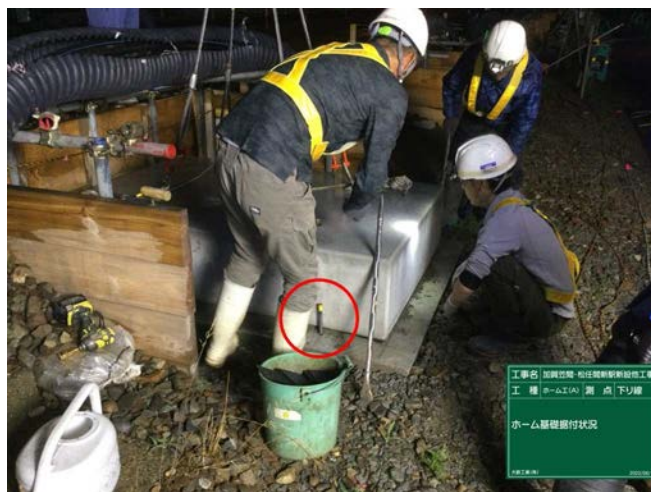
写真-2 基礎据付状況
