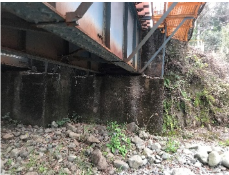
写真-2 施工前（橋台）
