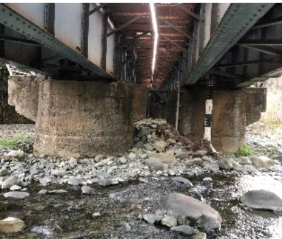
写真-1 施工前（橋脚）
