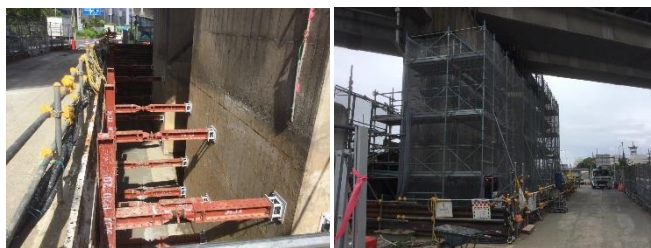
写真-8 掘削土留施工状況
