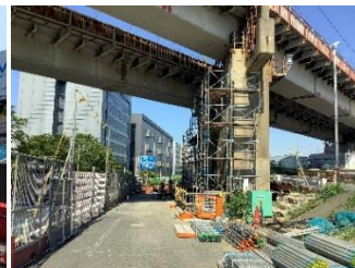
写真-4 常設作業帯設置
