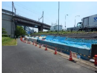
写真-3 EPS 盛土施工状況
