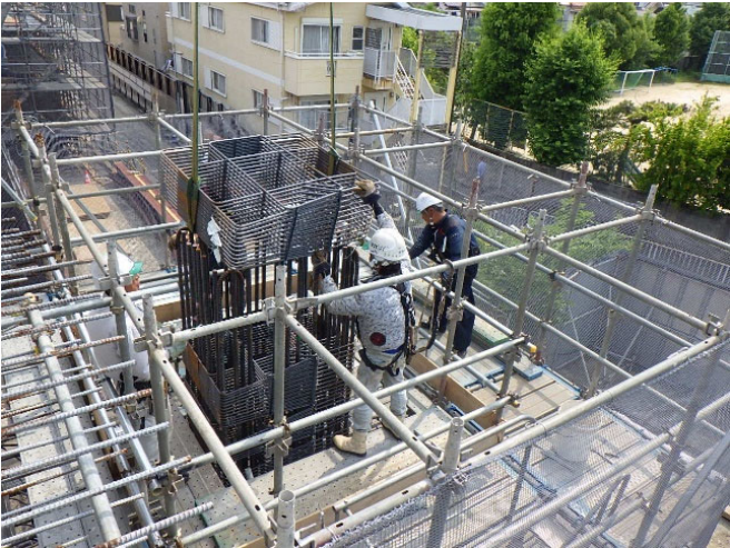
写真-2 ウルボン 1275 配筋状況（10 段～15 段）
