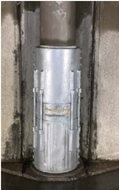
図ー1 耐震補強電化柱
