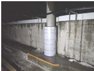
<養生鋼板設置完了>
