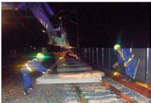
写真-1 L 型吊り治具による取卸し状況
