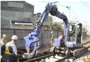
写真-2 まくらぎグリッパーによる把持状況
