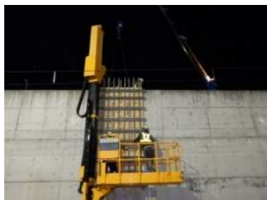
写真 3 橋梁点検車使用状況
