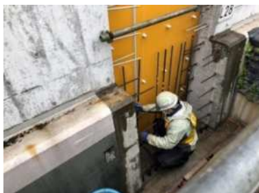
写真 2 軌道側型枠建込後
