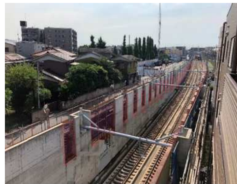
写真 1 躯体構築工事範囲
