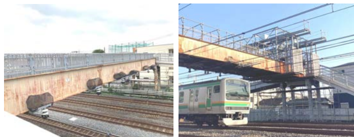
a)吊り足場設置前
