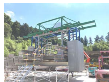
図-5 試験施工状況
