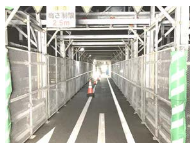
図-8 歩行者通路確保状況
