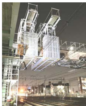
図-7 移動式足場設置状況
