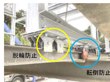
図-6 転倒・脱輪防止装置
