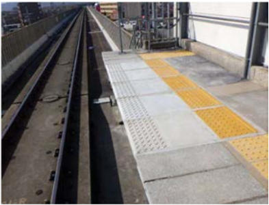
図-8 試験施工後
