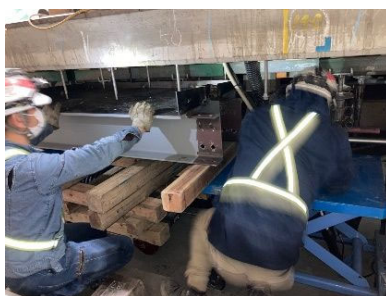
写真-2 盛替鋼材架設状況
