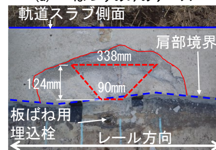
(b) はつり後に溝を設けたケース
