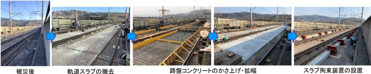
図－３ 復旧作業の様子
