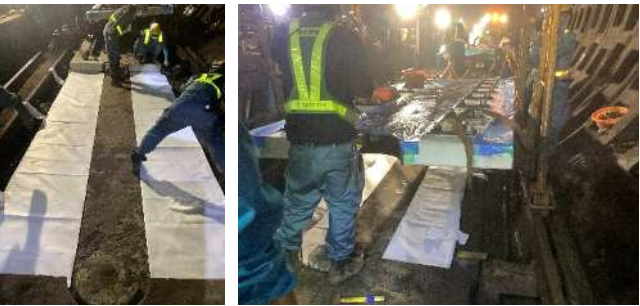
写真 1 枠型スラブ用ロングチューブを用いた施工
