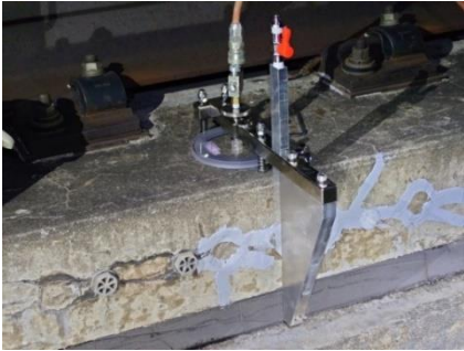
写真3 側面の注入 (圧力調整注入工法)
