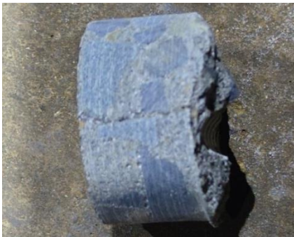
写真5 コアのひび割れの閉塞確認
