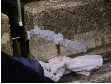
写真4 スラブ間の注入 (圧力調整注入工法)
