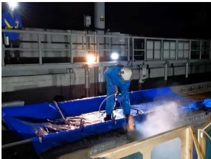
写真 2 劣化部の WJ はつり状況
