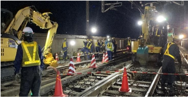
写真-2 道床バラスト交換
