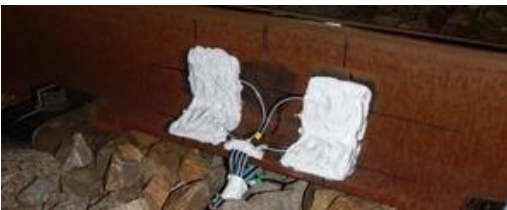
図 4 輪重横圧ゲージ設置状況
