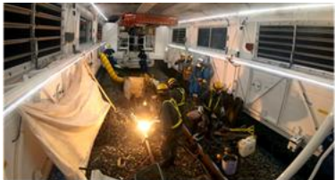
写真-3 レール溶接
