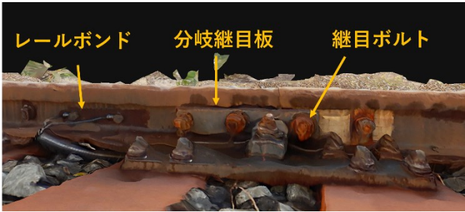
図2 継目箇所の3次元モデル例
