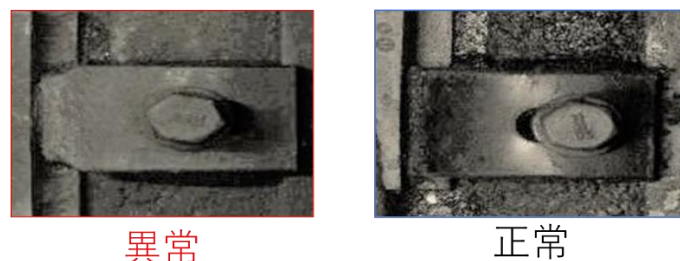
図1 締結装置の異常
