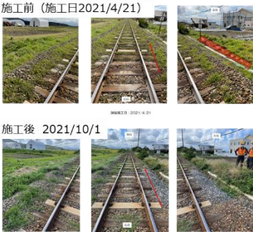
図3 MTT同時端掘工法前後の全景（右側端掘）
