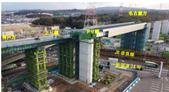
写真-2 橋りょう架設状況
