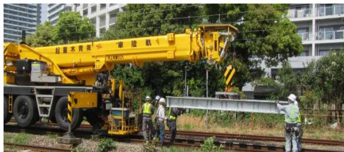
写真 1 50t 軌陸クレーン
