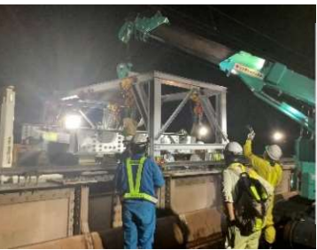
③門型クレーン設置
