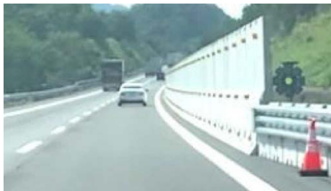
写真-2 仮設落石防護柵
