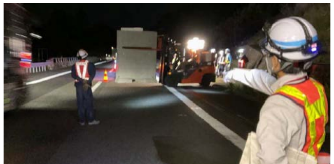
写真－6 安全パトロール実施状況
