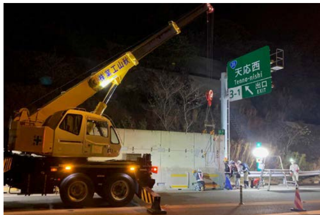
写真-3 移動式クレーンによる仮設落石防護柵設置
