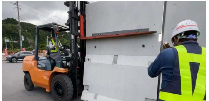
写真－5 試験施工
