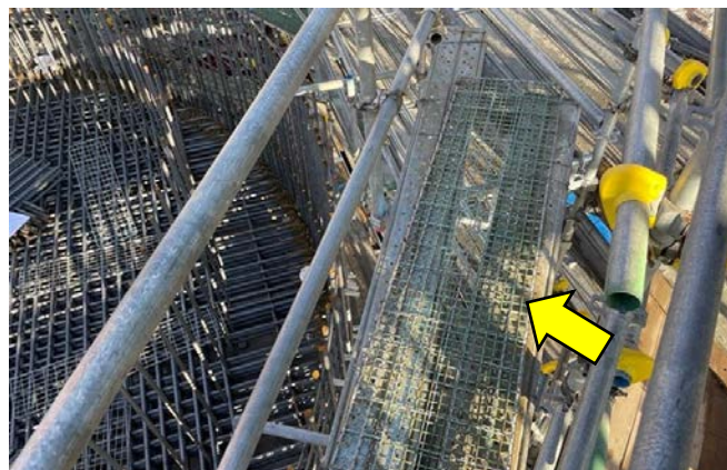
図-8 ブラケット足場隙間埋め状況
