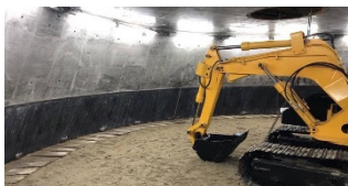
図-2 作業室内状況
