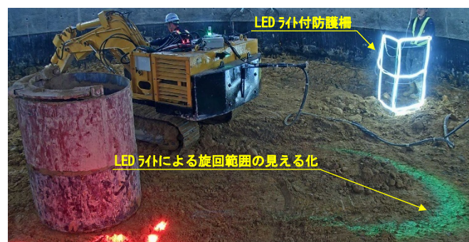
図-5 掘削作業 安全対策 見える化
