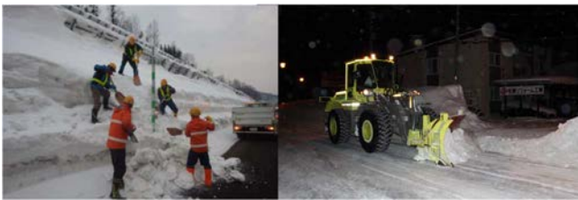
図1 除雪作業員による除雪作業と除雪重機の稼働
