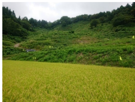
図-3 試験を実施した法面
