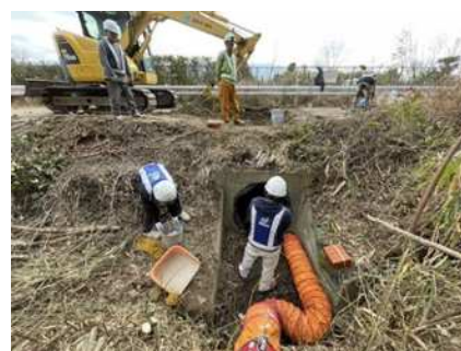
写真. 1 コルゲートパイプ補修状況
