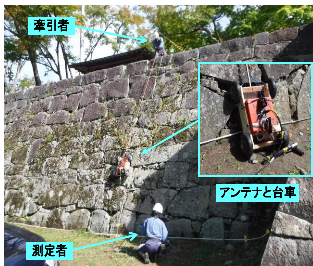
写真-1. 石垣レーダ測定状況
