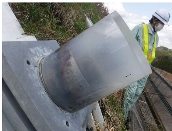
写真-3 シリコーンの白濁状況
